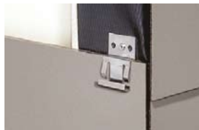
Detalle esquina exterior sin perfil
